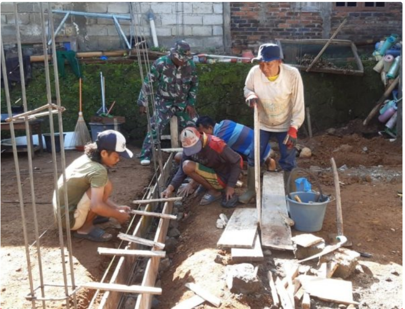
Pemasangan Bekisting Balok Sloof
